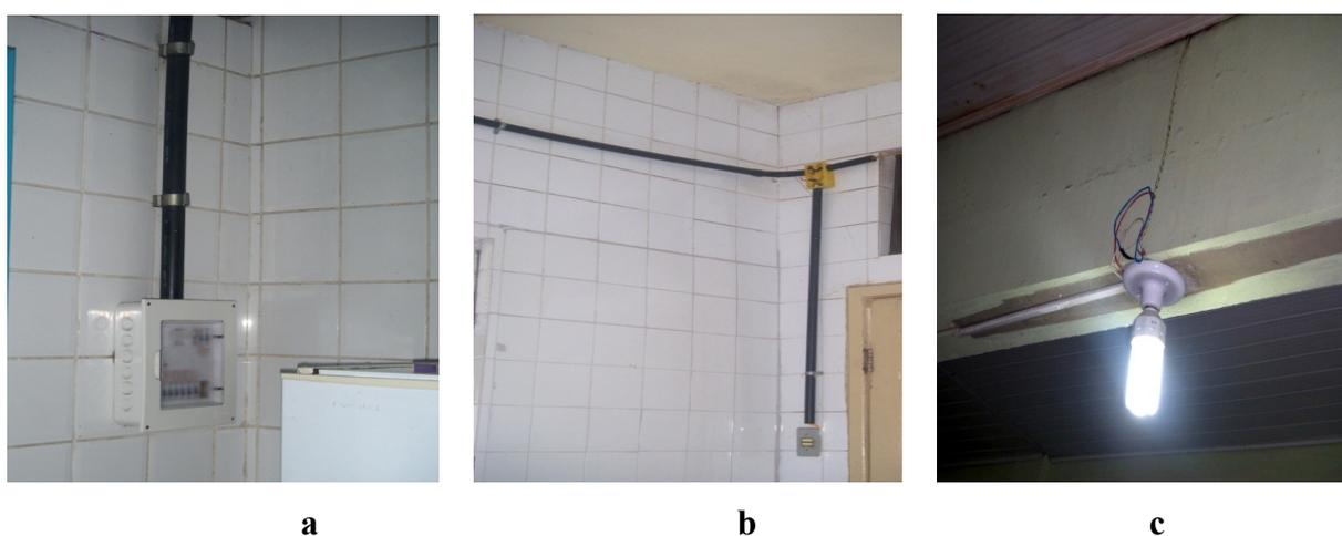
FIGURA 6 – Imagem (a) e imagem (b) – Instalações elétricas protegidas em tubulações. Imagem (c) – lâmpada sem proteção contra estouros ou quedas; instalação elétrica desprotegida (à mostra).
